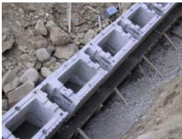
写真-3 コンクリート打設状況
