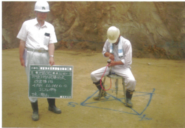
地盤改良後のPCタンクの基礎確認（7層7mの各段毎に広範囲確認 全50ヶ所以上）
