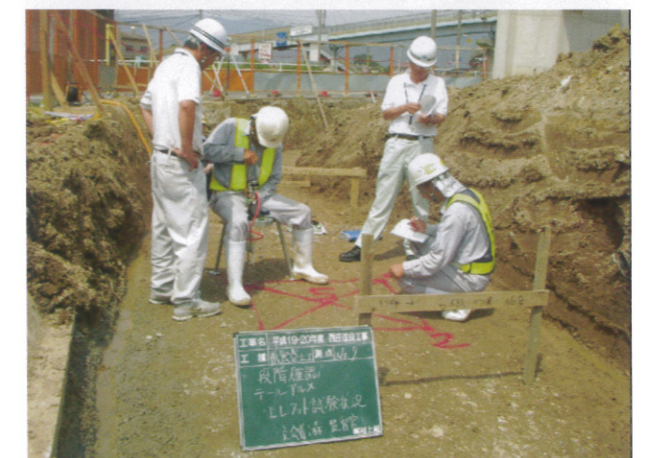
テールアルメの基礎確認 (全4ヶ所)
