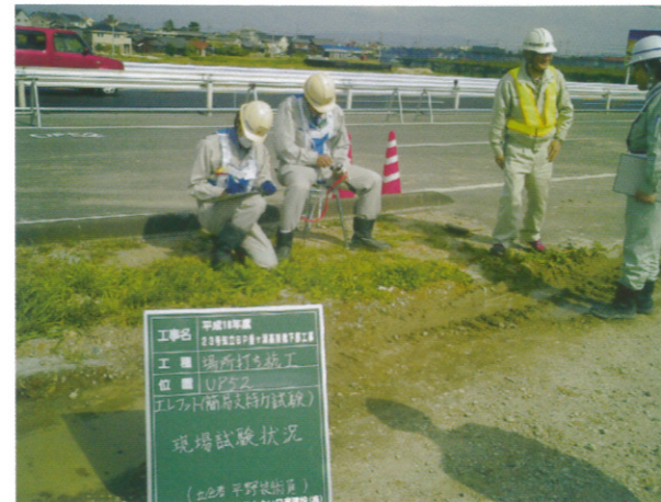
場所打ち杭工支持力確認 (全6ヶ所)
