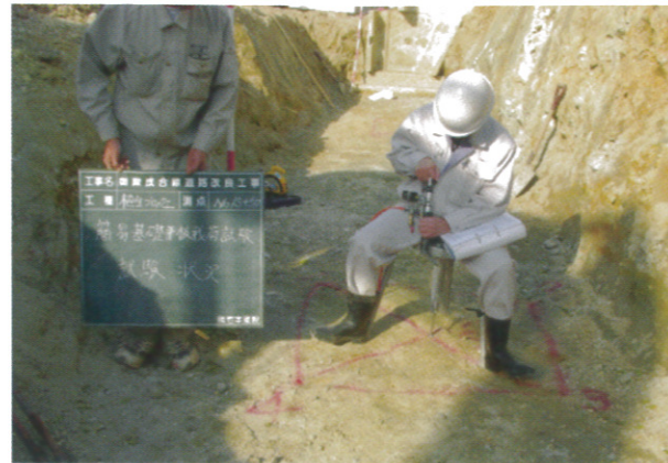
バランス工法擁壁（逆台形）の基礎確認（全5ヶ所）
