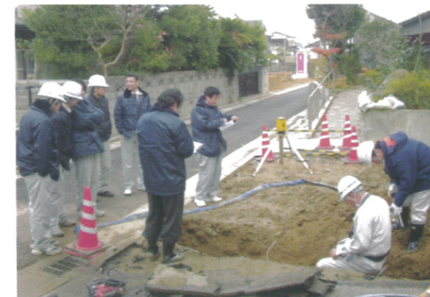
重力式擁壁の基礎確認（全2ヶ所）
