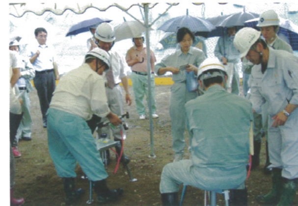
大型貯水槽の基礎確認他（全3ヶ所）
