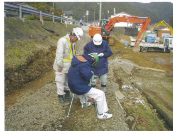
L型擁壁の基礎確認 (全3ヶ所)
