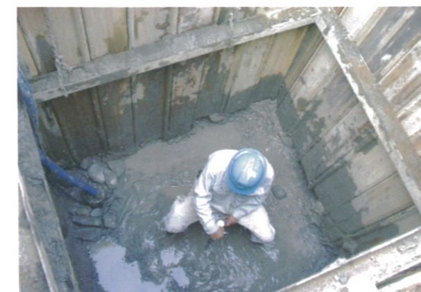
下水マンホールの基礎確認（1ヶ所）
