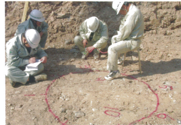
砂防ダム基礎確認（全3ヶ所）
