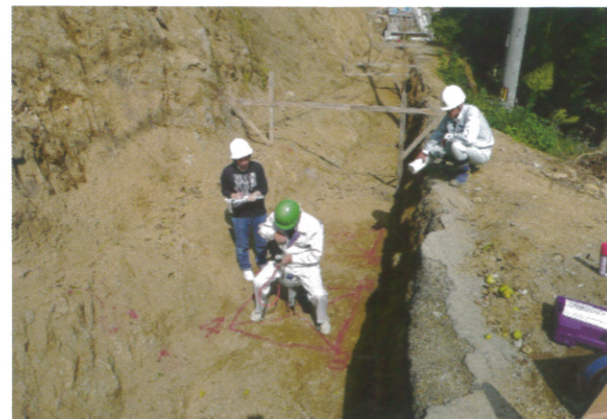
堰堤の基礎確認（全3ヶ所）
