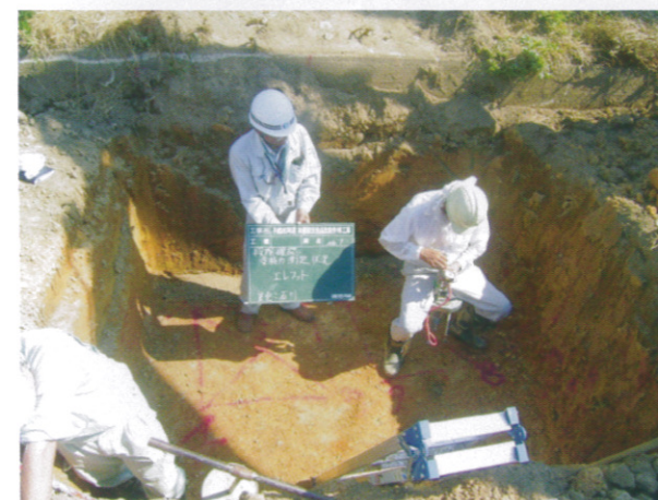
大型ブロックの基礎確認 (全3ヶ所)
