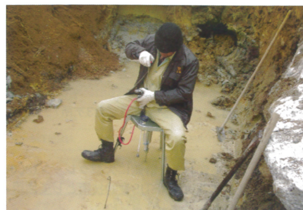
ボックスカルバートの基礎地盤確認（全2ヶ所）
