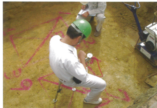
重力式擁壁基礎確認（全3ヶ所）
