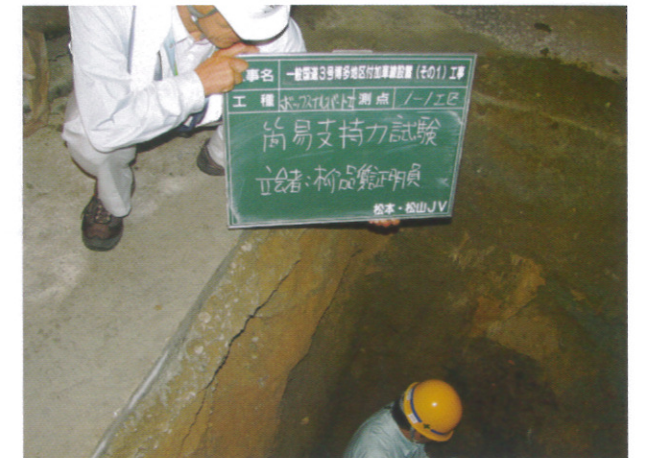
ボックスカルバートの基礎支持力確認 (1ヶ所) 夜間
