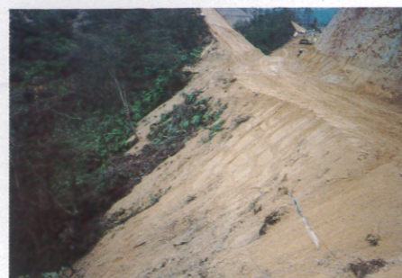
①工事着工前
