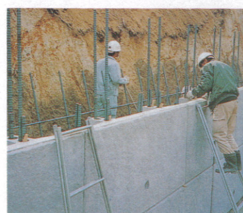
⑩フロントブロック設置
