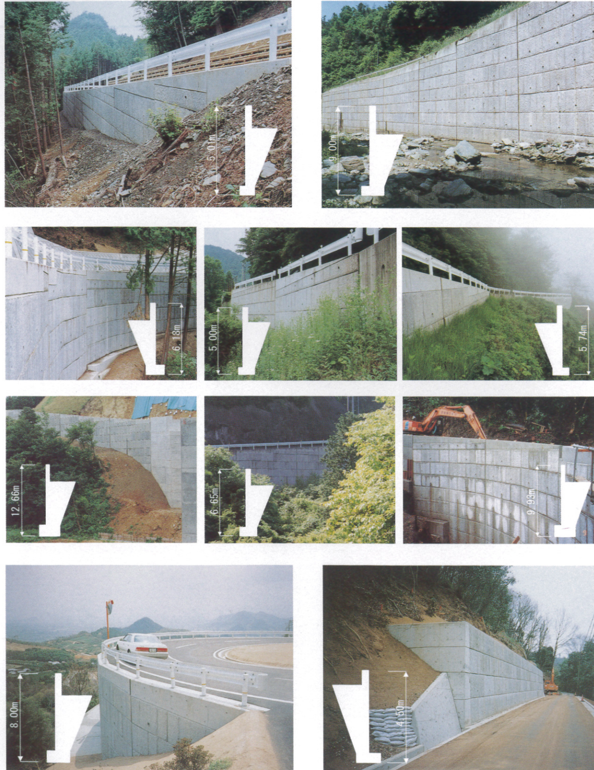
【道路拡幅への利用】
