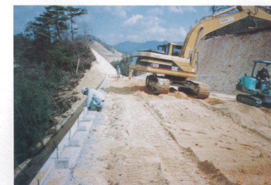
⑬完成間近天端状況
