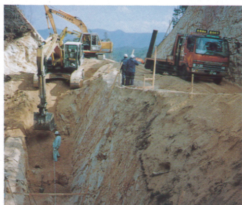
②基礎掘削
