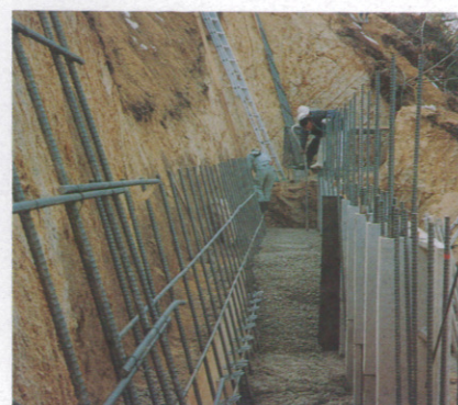
⑨背面側コンクリート打設
