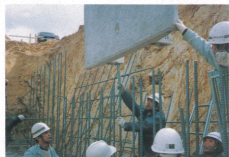
⑥フロントブロック設置
