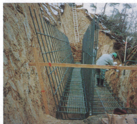
④鉄筋組み立て
