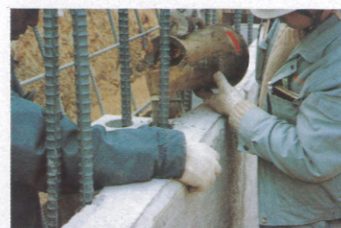
⑦フロントブロック固定
