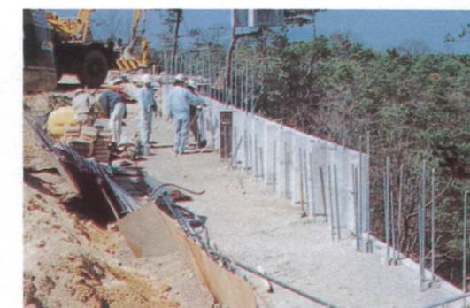
⑫擁壁背面側状況
