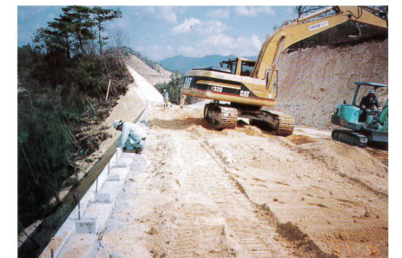
⑬完成間近天端状況
