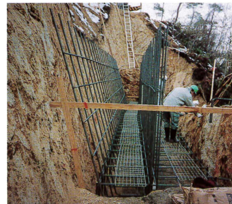
④鉄筋組み立て
