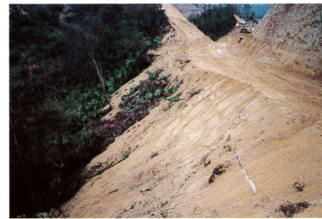
①工事着工前
