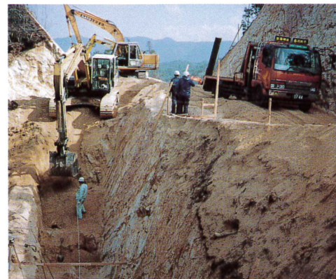
②基礎掘削
