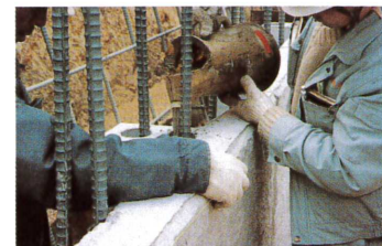
⑦フロントブロック固定
