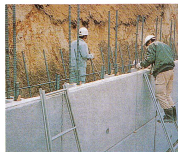
⑩フロントブロック設置
