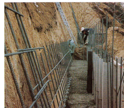
⑨背面側コンクリート打設
