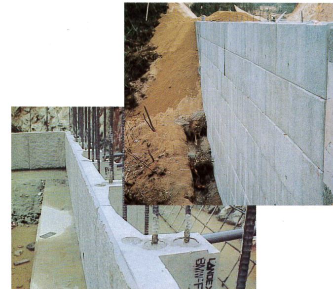
⑪擁壁前面側状況
