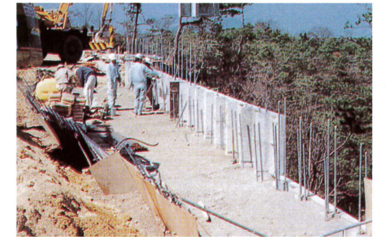
⑫擁壁背面側状況
