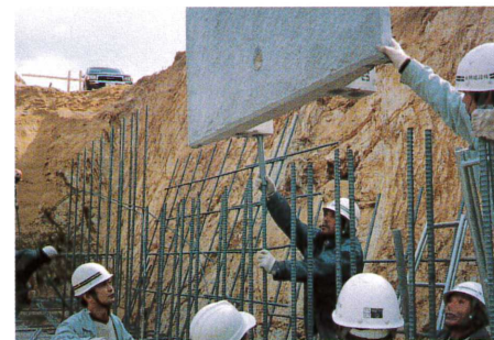
⑥フロントブロック設置
