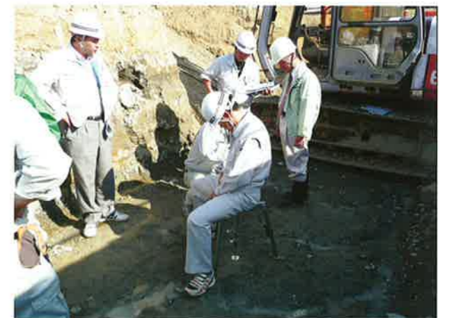
ボックスカルバートの基礎支持力確認 (全2ヶ所)
