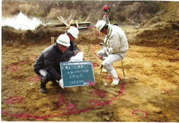
転圧状況の確認（広範囲に試験しました。全12ヶ所）
