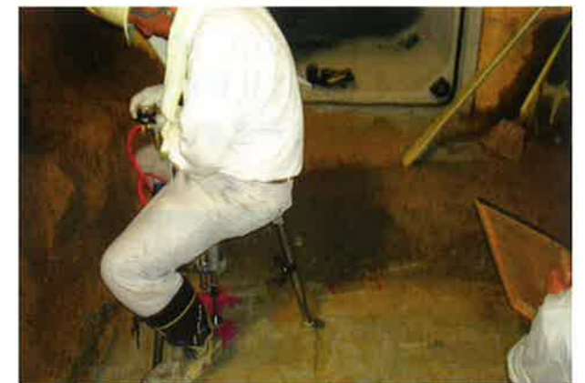
国道カルバート横断の基礎確認（夜間）（全2ヶ所）
