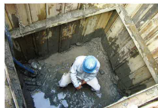
下水マンホールの基礎確認（1ヶ所）
