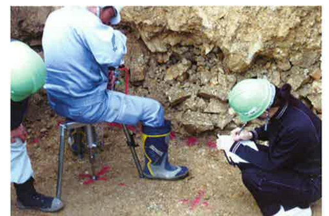
バランス工法擁壁の基礎確認（全1ヶ所）
