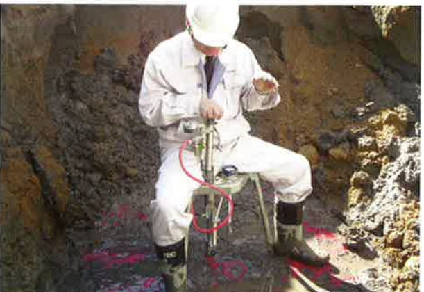
ボックスカルバート基礎地盤確認（全1ヶ所）
