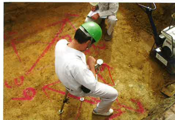
重力式擁壁基礎確認（全3ヶ所）
