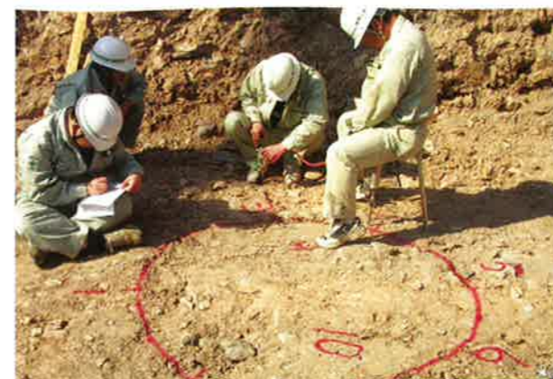
砂防ダム基礎確認（全3ヶ所）
