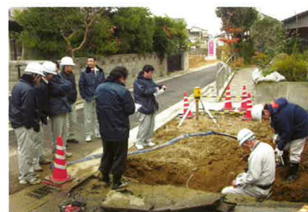
重力式擁壁の基礎確認（全2ヶ所）
