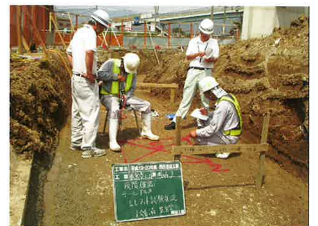
テールアルメの基礎確認 (全4ヶ所)
