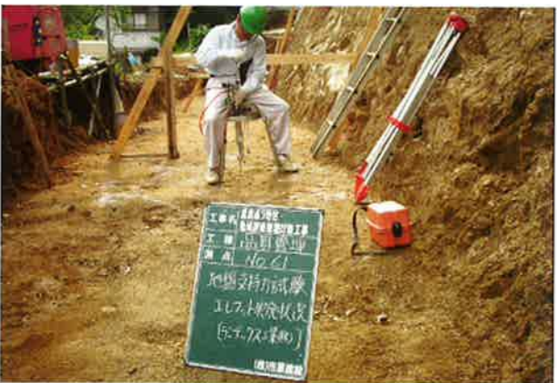
もたれ擁壁の基礎確認（全7ヶ所）
