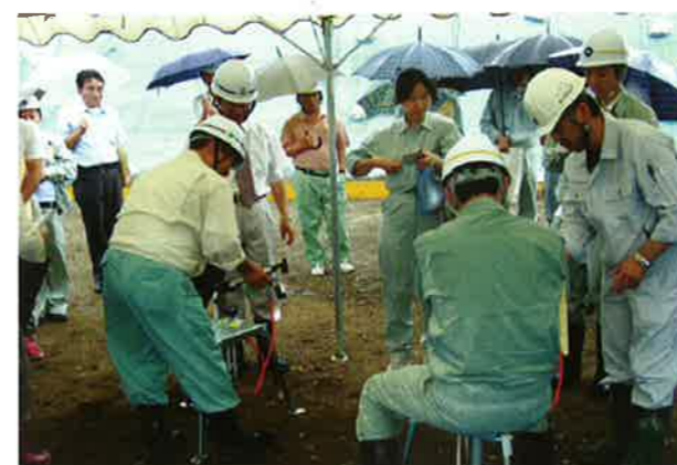
大型貯水槽の基礎確認他（全3ヶ所）
