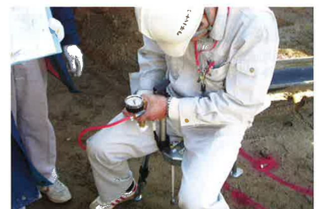
アーチカルバートの基礎確認（全2ヶ所）
