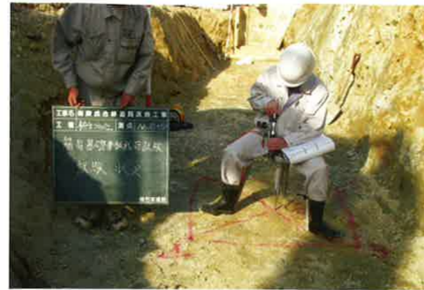
バランス工法擁壁（逆台形）の基礎確認（全5ヶ所）
