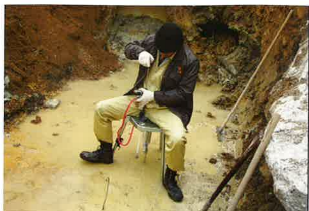
ボックスカルバートの基礎地盤確認（全2ヶ所）
