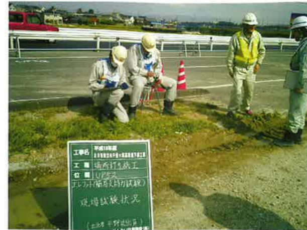
場所打ち杭工支持力確認 (全6ヶ所)
