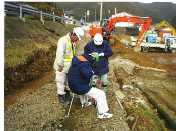
L型擁壁の基礎確認 (全3ヶ所)
