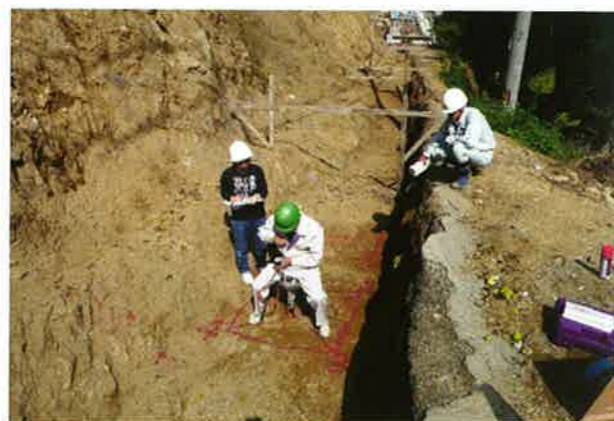
堰堤の基礎確認（全3ヶ所）
