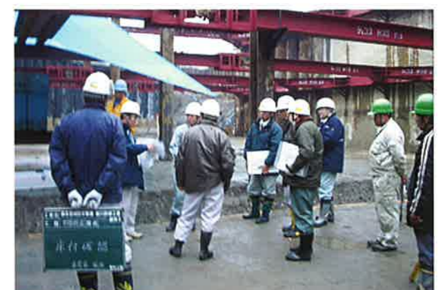
河川超大型水門の基礎確認（広範囲に試験しました。7ヶ所）
